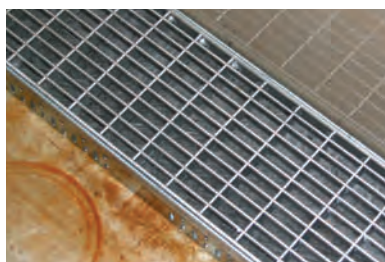
Ein eingelegtes Schmutzvlies reduziert bereits im sauberen Zustand die hydraulische Leistung des Systems um 30%
