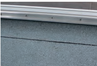
Anschluss einer bituminösen Abdichtung mit Keilbildung
