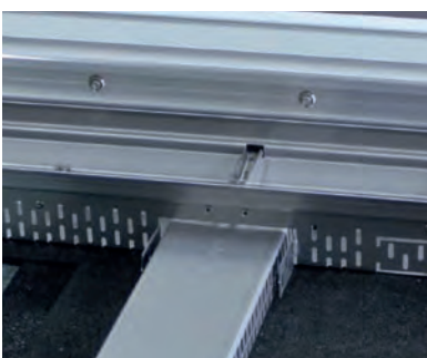
Einschieben des Stichkanals in die Rinne. Zu empfehlen sind min. 2 Stichkanäle mit einer Länge von 50 cm pro Meter Rinne
