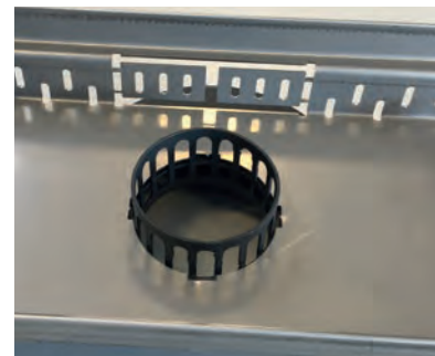
Einsetzen des Einsteckstutzens
