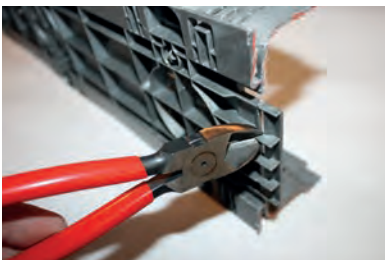
Kürzen des Rinnenendes im Bodenbereich
