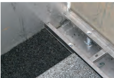
Rinnensystem lose verlegt
