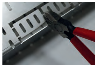
Öffnen des Stichkanalanschlusses
