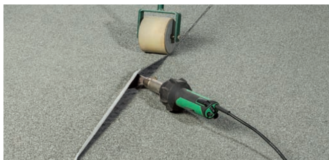
Aktivierung des Thermrands mittels Heißluftgerät.
