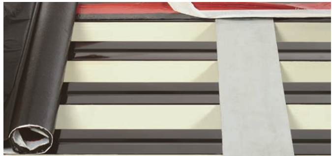
Verlegen der MOGAFIX KSK-D Uni auf Trapezblech, sicherer Kopfstoß durch Einsatz eines Unterlagsblechs.
