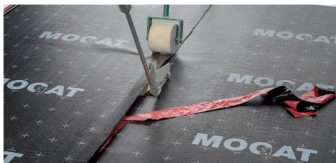
Bei thermischer Aktivierung wird gleichzeitig der rote Nahtstreifen entfernt.
