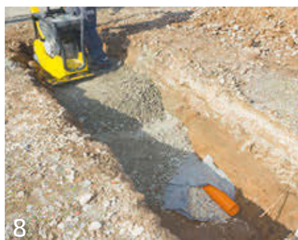
8 Lagenweise einfüllen und verdichten von Schotter bis ca. 30–40 cm unter Geländeoberkante. Dieses Maß ist abhängig von dem verwendeten Mauerstemsystem.
