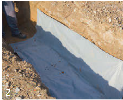
2 Ausbreiten des Geotextils Klasse III ca. 200 gr./m 2 . Fixierung an der aufgehenden Grabenwand.
