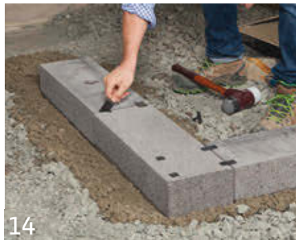
14 Anschließend den folgenden Stein setzen und wie vorgeschrieben verfahren. Kontrollieren Sie, dass der Stein die exakte Verlängerung des Schenkels des rechten Winkels ist.
