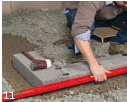
11 Flucht mittels Richtlatte oder Schnur kontrollieren.
