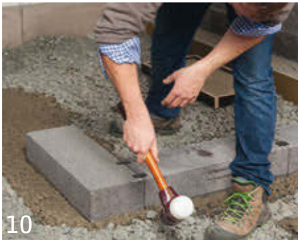
10 Den fluchtgerecht gesetzten Kombistein hammerfest angeschlagen.
