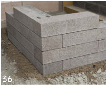
36 Ein exaktes Arbeiten, Stein für Stein, garantiert den geraden Aufbau der Mauer bis zur letzten Steinreihe.
