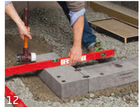
12 Höhenlage mittels Richtlatte oder Schnur kontrollieren und wenn nötig anpassen.
