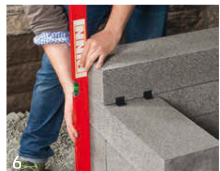
6 Alle Steine müssen an den Ecken bündig sitzen.
