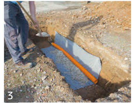
3 Auslegen der Dränleitung und Anschluss an eine vorhandene Vorflut oder Versickerungseinrichtung. Abdecken der Dränleitung mit Dränagesplitt 8/16 oder 16/22. Achtung: Kein Splitt unter die Dränleitung!
