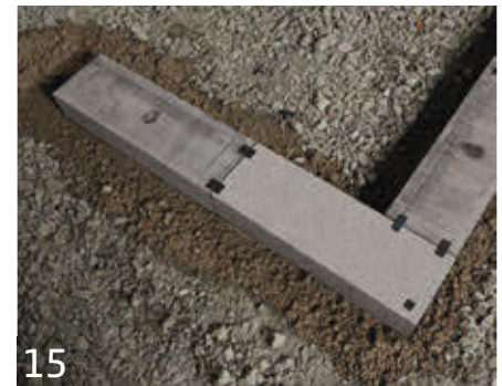
15 Nach Fertigstellung der ersten Reihe wird nochmals in Längs- und Querrichtung gefluchtet und ausgerichtet. Anschließend warten, bis der Fundamentbeton leicht angezogen hat.
