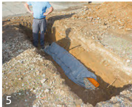
5 Umschlagen des Geotextils um die Splitt-Abdeckung der Dränleitung. Auf ausreichend Überlappung des Geotextils ist zu achten.
