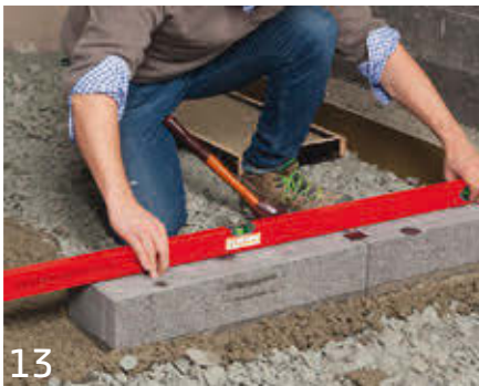
13 Die Höhenlage muss über alle Steine hinweg exakt ausgerichtet sein.
