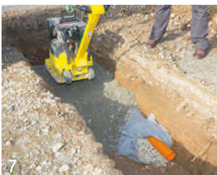
7 Verdichten der eingebrachten Lagen mit geeignetem Gerät.
