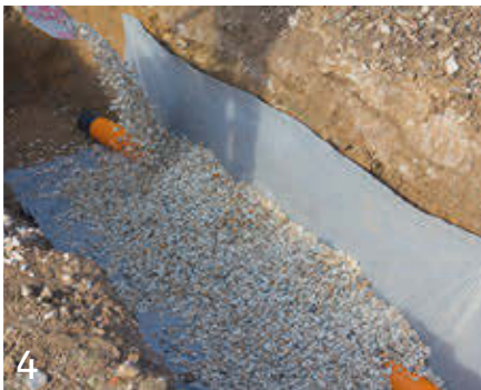
4 Abdecken der Dränleitung mit Splitt in den Körnungen 8/16 oder 16/22.
